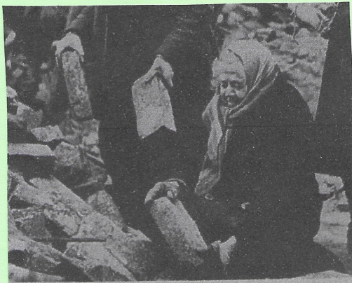
Überlebende bei Enttrümmerungsarbeiten.
